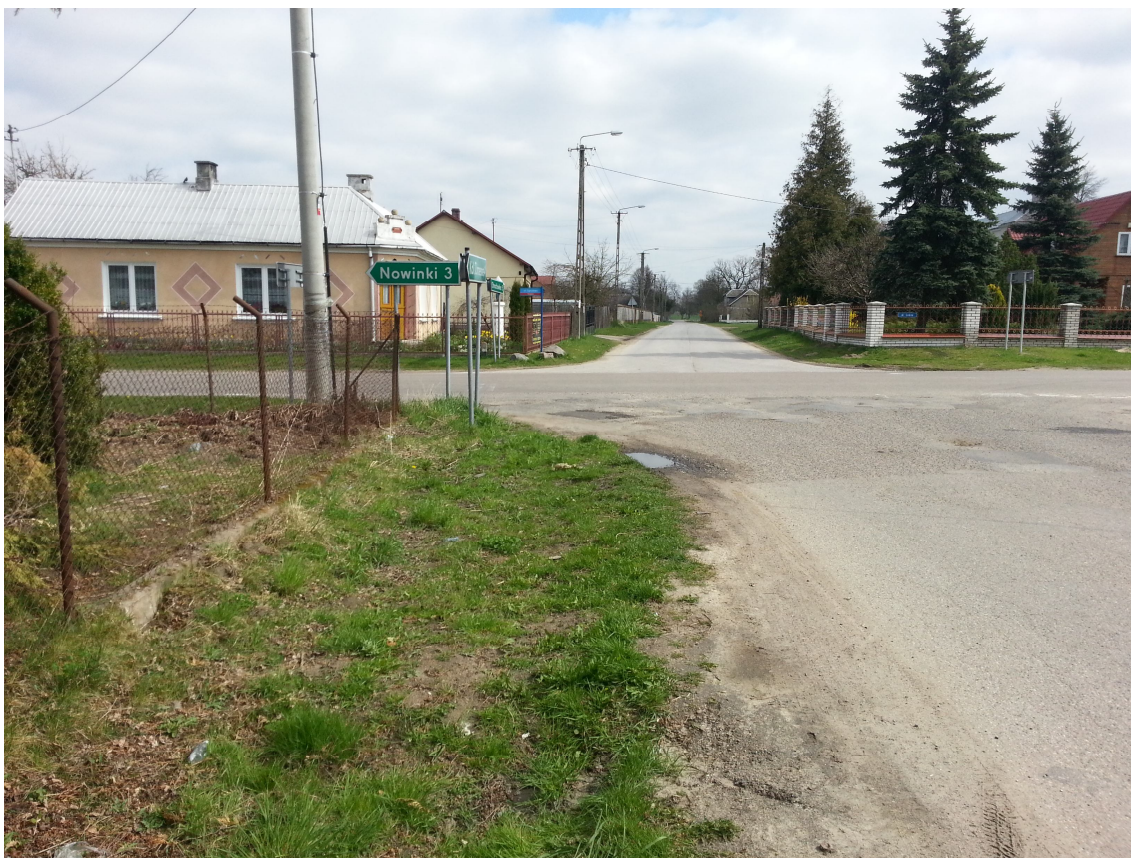
Fot. 1 Widok na skrzyżowanie ul. Kościelnej z ul. Leśna.
